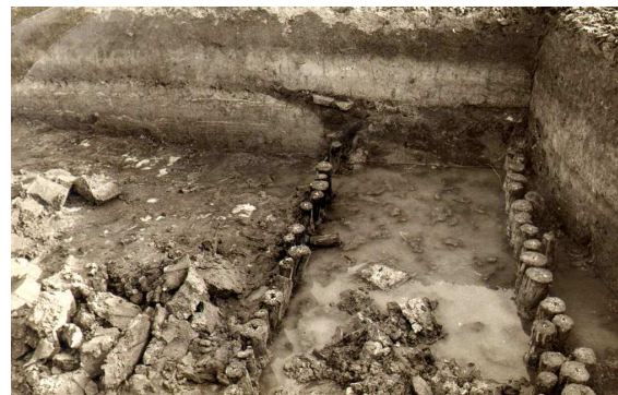
Restanten van de houten beschoeiing en kade tijdens de opgraving in de jaren '50.
